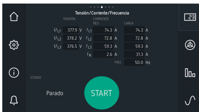
Figura 56: Visualización de la Tensión, Corriente y Frecuencia.
